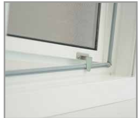
Fliegengitter-Rahmen von innen durch das Fenster nach Außen reichen.
