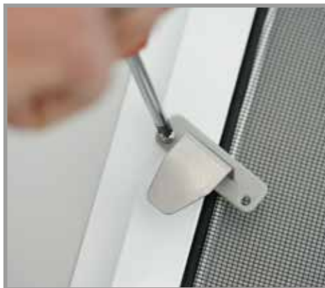
Universa-Klammern auf dem Rahmen verschrauben.
