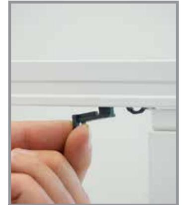
Laufwagen rechts und links in das Laufwagenprofil stecken.
