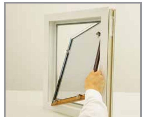
Fliegengitter-Rahmen von innen durch das Fenster nach Außen reichen.
