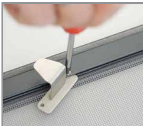
Universa-Klammern in die Nut stecken und verschrauben.
